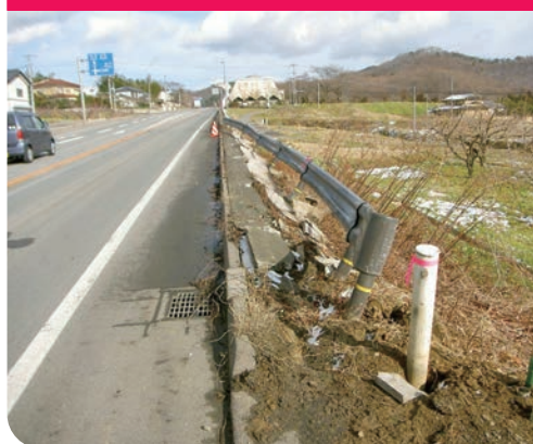
ガードレール・標識等の損傷
