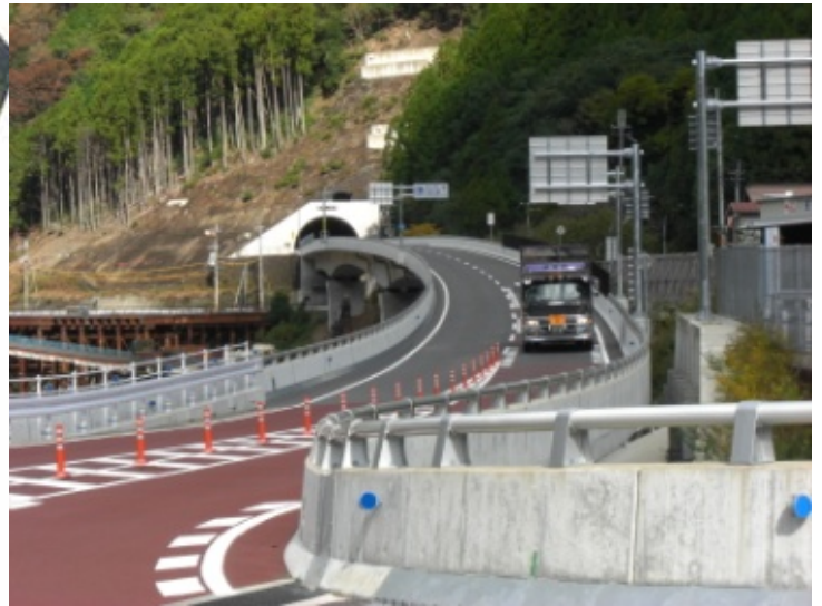
今戸高架橋(折立出入口側)
