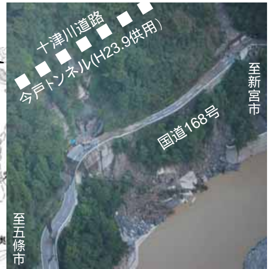
十津川道路並行区間(折立地区)の被災状況 (撮影日:平成23年9月6日)
