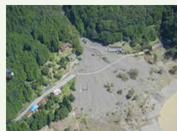
土砂崩落など大きな被害が出た国道168号の長殿区間（平成23月9月）
