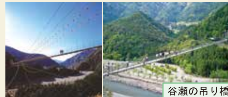
谷瀬の吊り橋
