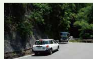
線形が厳しい国道168号
