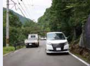
▲現道の国道168号(十津川村桑畑周辺 令和2年8月)
