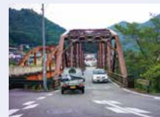
▲国道168号庵之前橋付近(令和2年8月)
