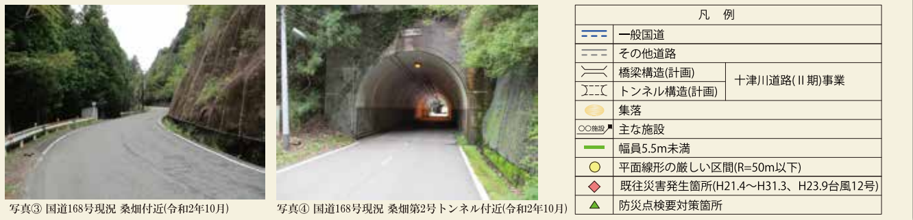
写真③ 国道168号現況 桑畑付近(令和2年10月) 写真④ 国道168号現況 桑畑第2号トンネル付近(令和2年10月)
