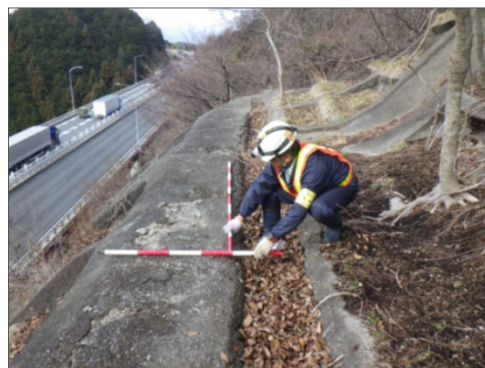
〔道路土工構造物点検〕
