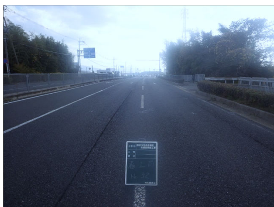
〔補修前(国道24号)〕
