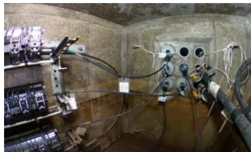
マンホール内写真
