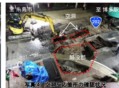
写真④ 空洞反応箇所の確認状況
