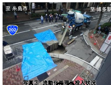
写真③ 流動化処理土投入状況
