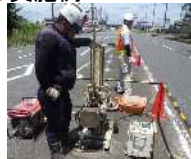
(貫入試験による調査)
