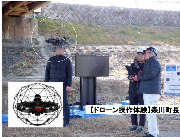
ドローンを活用した橋梁点検技術(ELIOS3)
