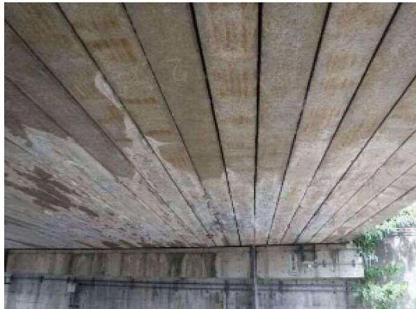
[写真 1-4 桁のひび割れ・不揃い・たわみ]
