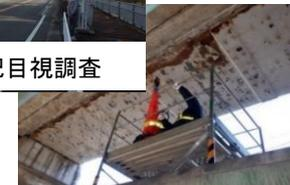
桁下面の打音及び板厚調査
