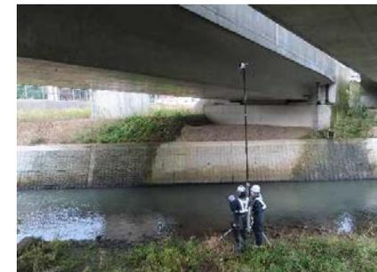
・ロボットカメラの点検イメージ
