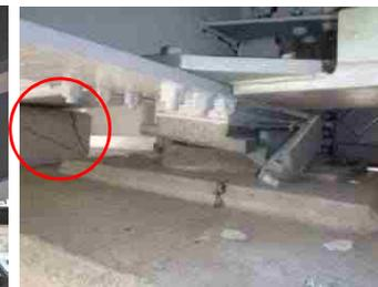
写真-6 支承の破損の状況
