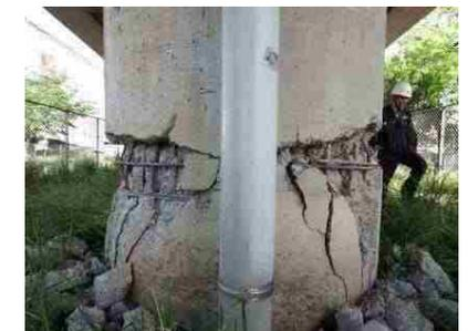
写真-7 段落し部の損傷
