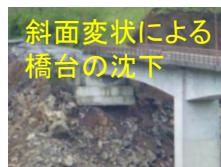
大規模な斜面崩壊による橋台の沈下等の事例が存在したため、地質・地盤調査、橋の設置位置等について考慮する必要
