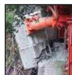
（制震ダンパー取り付け部の損傷により、制震ダンパーが機能しない事例が存在したため、部材接合部について留意する必要）
