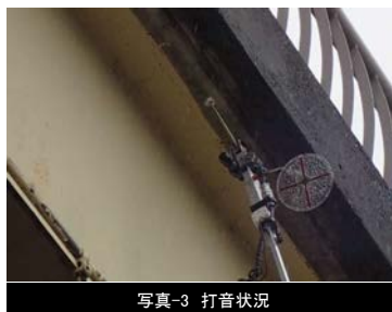
写真-3 打音状況
