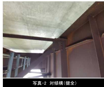
写真-2 対傾構(健全)
