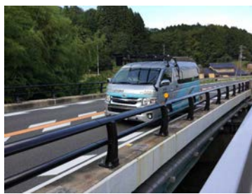
写真-3 点検状況(前方)
