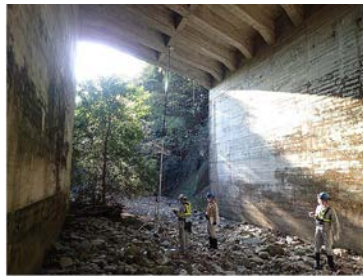
写真-1 点検状況
