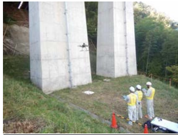
写真-1 点検状況
