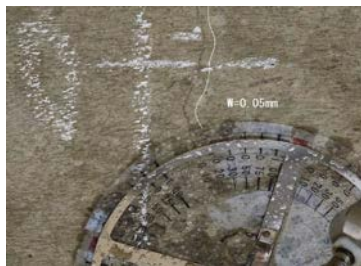
写真-1 クラックゲージによるひびわれ幅の測定状況
