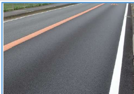
【損傷度Ⅰ：健全】 舗装が新しく望ましい段階
