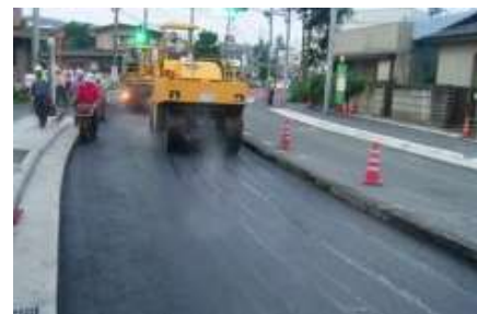
【舗装修繕(打換え工)】
