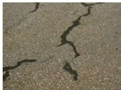
【シール材注入工法】
