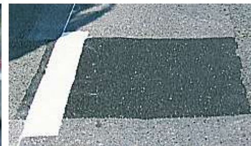
【局部補修(パッチ補修)】
