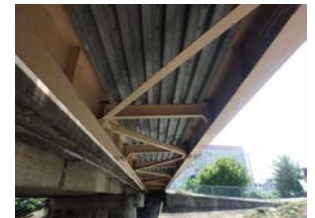
・三山橋側歩道橋(上)の桁下面
