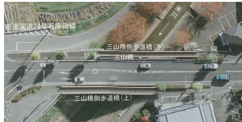
・三山橋側歩道橋(上)(下)の航空写真 (H22.11)
