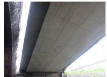
・針I・CBランプ橋の桁下
