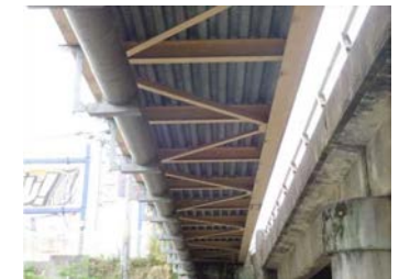
・十市橋側歩道(下)の桁下面
