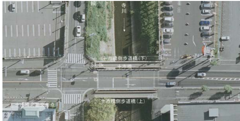
・十市橋側歩道橋(上)(下)の航空写真 (H22.11)
