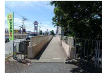
・十市橋側歩道橋(上)の正面
