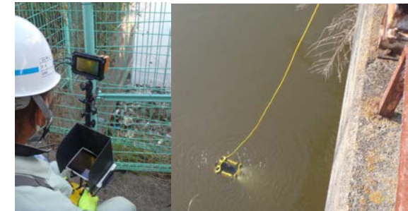
・水上・水中ドローンの点検イメージ
