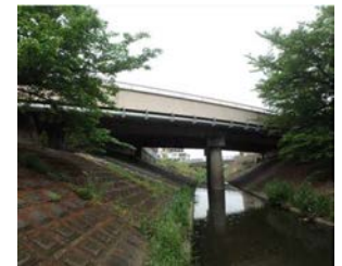
・三山橋側歩道橋(下)の側面
