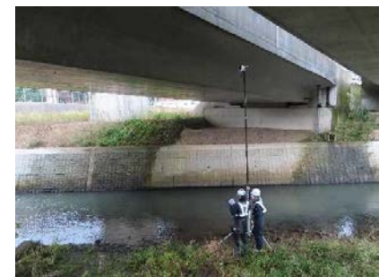
・ロボットカメラの点検イメージ
