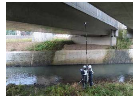
・ロボットカメラの点検イメージ
