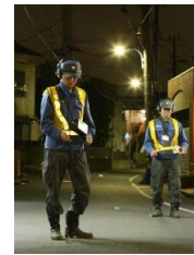
道路下の漏水調査
