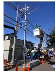
元位置工具新設
