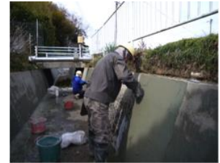
地域住民が作業員として参加し、直営で施工
