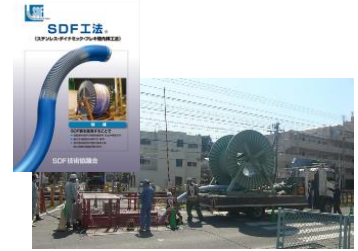
SDF工法の施工状況
