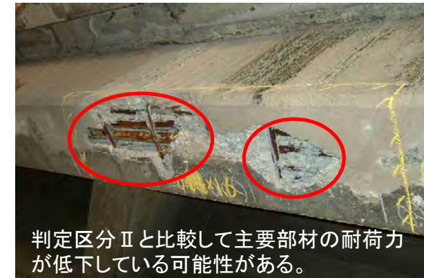
判定区分Ⅲ(主桁の断面欠損)
