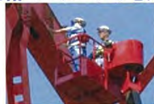
直轄診断(三島大橋)
