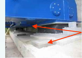
支承交換が容易な構造の例
