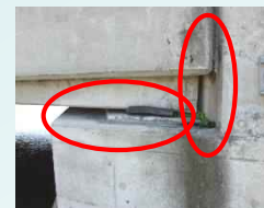
支承交換や桁端点検の空間なし
