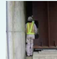
支承交換や桁端点検の空間なし
