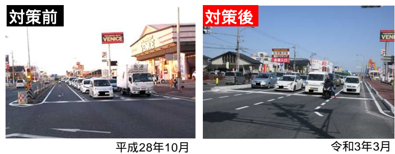
左折レーン設置状況(写真)
