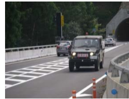
写真C: 「緊急」開通状況 (平成23年9月6日撮影)
