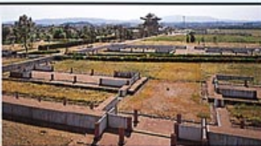
兵部省の整備 武官人事を担当していた役所。現代の道路が中央を横切っていますが、建物の柱や礎石を、約1mほど立ちあげる半立体復原という手法を用いて整備しました。
