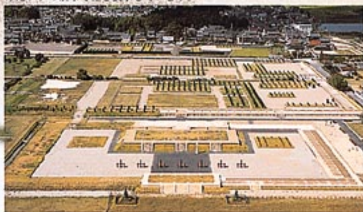
第二次大極殿と内裏の整備 第二次大極殿とその周辺にある礎石建物は基壇を復原、内裏の圓立柱建物は、円柱状に割りあげたツグの植木で柱を表示しています。
