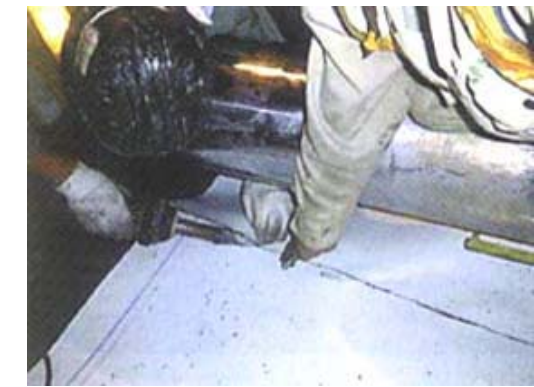
シート溶着状況
