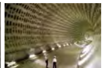
放水路トンネル
