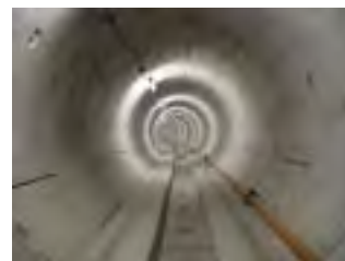
下水道トンネル
