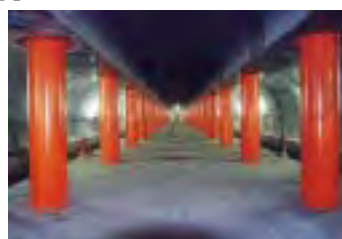
鉄道トンネル
