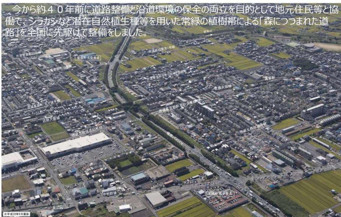
榿原市土橋町・曾我町地区付近
