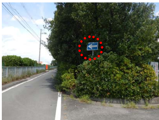
図 樹木による標識の視認性低下状況
