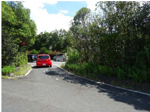
写真 樹木による視距不良状況
