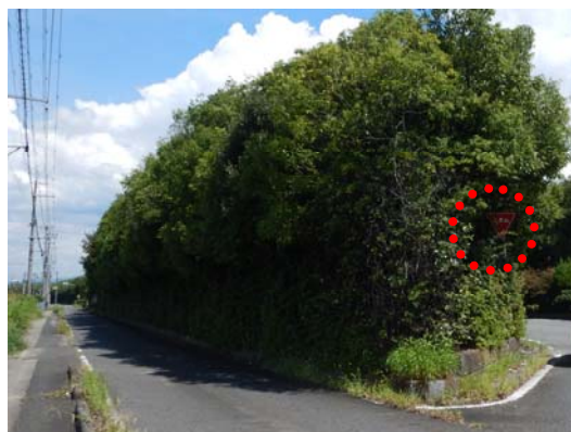
図 樹木による標識の視認性低下状況
