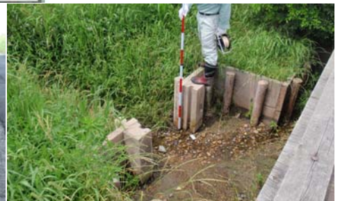
既設堰を利用し湛水
