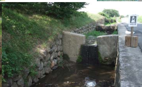
落差工の水通し部に仮設の堰を設け、湛水
