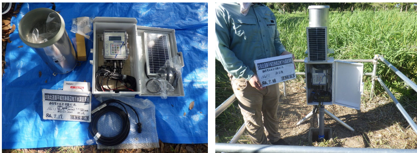
写真１ 通信型水位計の設置（左：機材一式、右：設置状況）
