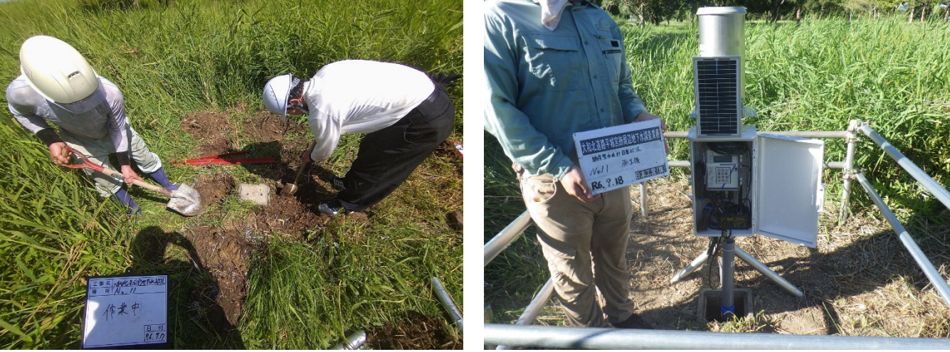
写真—3 通信型水位計（地上立上げタイプ）設置状況（左：施工中、右：施工後）
