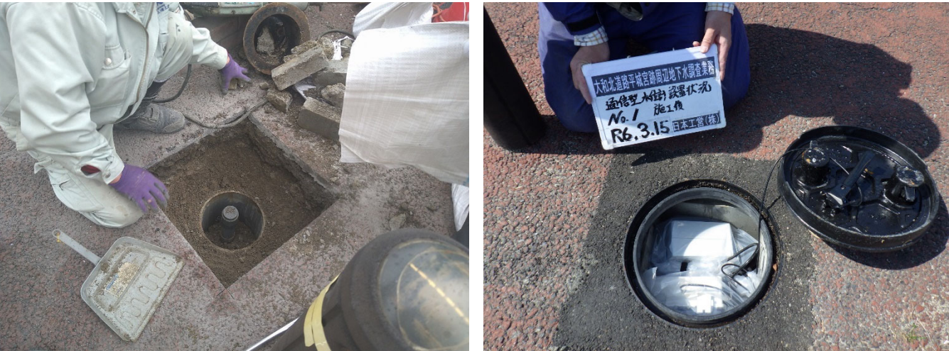
写真—2 通信型水位計（マンホールタイプ）設置状況（左：施工中、右：施工後）
