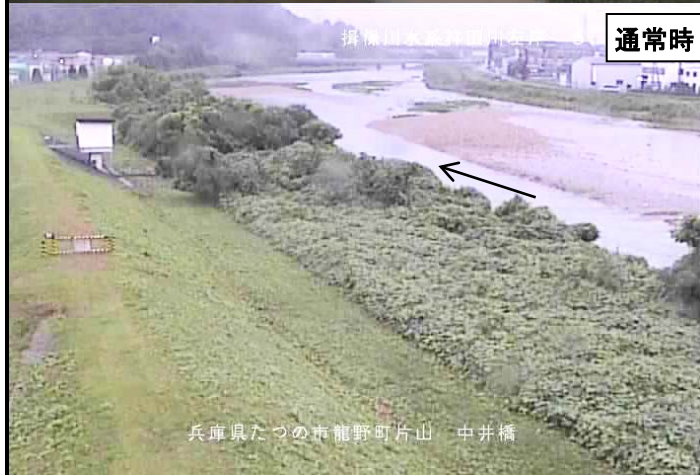
林田川6.8kp付近 中井橋
