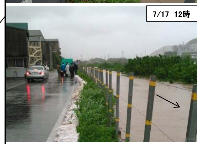
林田川6.4kp付近 水防活動状況 (土嚢積み)
