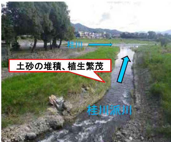
6号井堰下流 (桂川派川) 整備前の状況 (平成26年9月)
