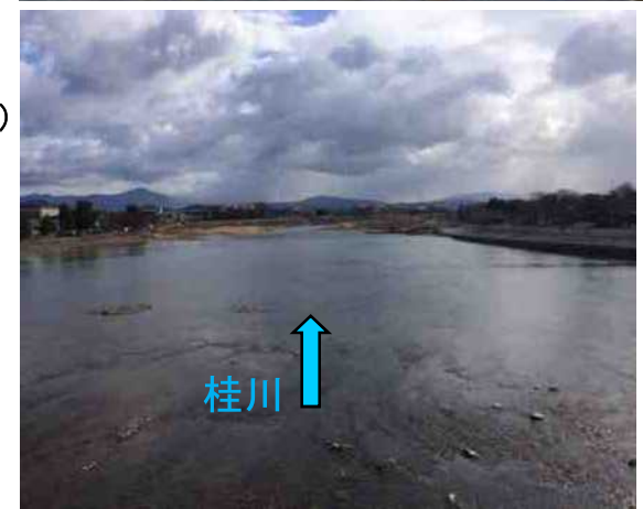
整備完了 (平成27年2月)
