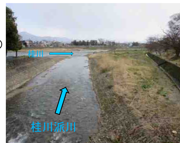
整備完了 (平成27年3月)
