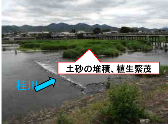
渡月橋上流 整備前の状況 (平成25年6月)
