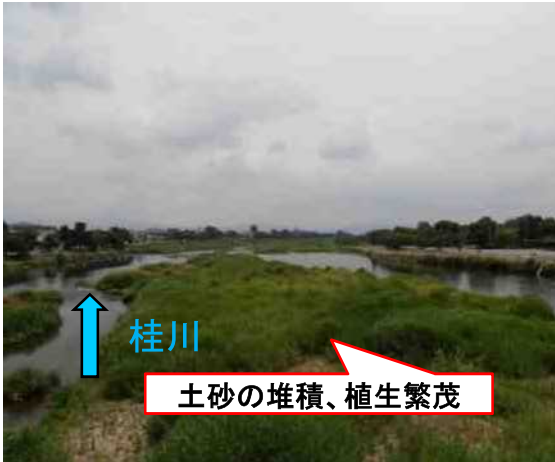
渡月橋下流 整備前の状況 (平成25年7月)
