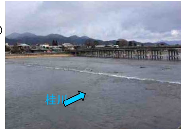
整備完了 (平成27年2月)
