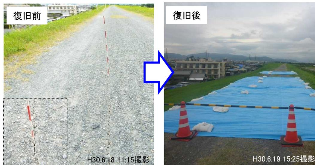
【⑬淀川本川31.2k左岸(枚方市):堤防天端の縦断亀裂】
