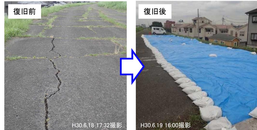
【⑤淀川本川22.8k右岸(高槻市):堤防天端の縦断亀裂】
