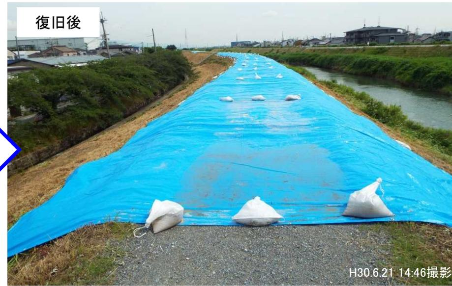
【①淀川28.5k右岸(高槻市):高水護岸損傷】(応急復旧)ブルーシート養生
