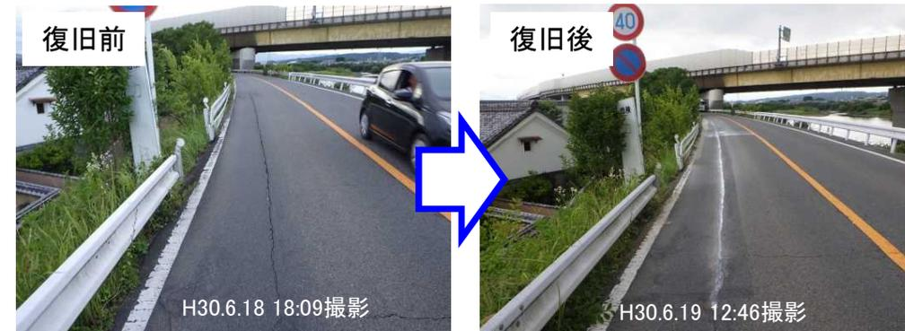
【③木津川1.6k右岸(八幡市):堤防天端の縦断亀裂】
