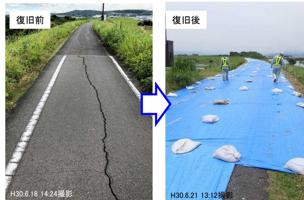
【⑧木津川11.8k右岸(城陽市):堤防天端の縦断亀裂】
