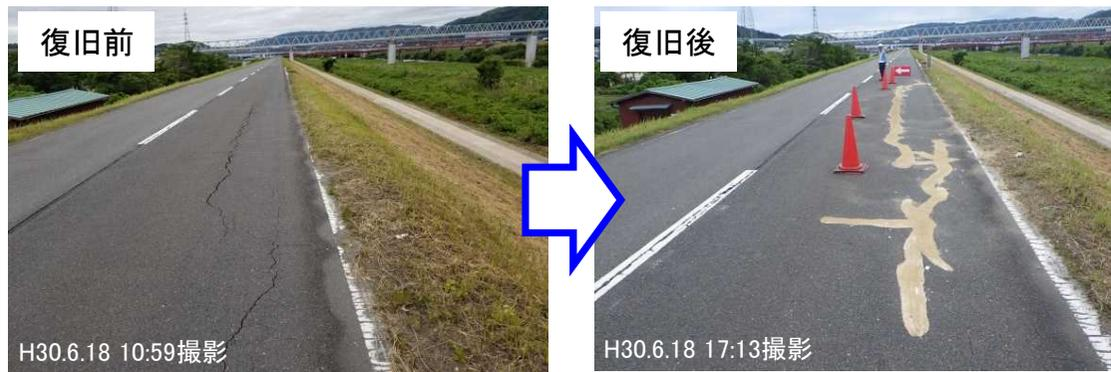
【⑫宇治川49.4k右岸(宇治市):堤防天端の縦断亀裂】
