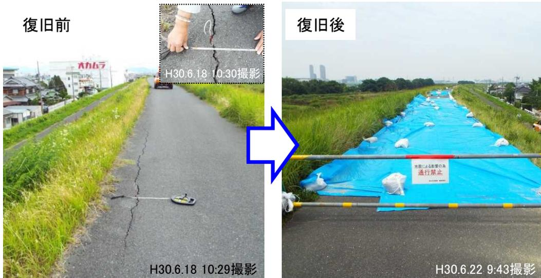
【⑭淀川本川21.8k左岸(寝屋川市):堤防裏小段の縦断亀裂】
