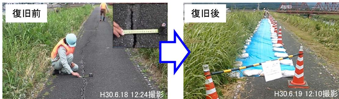
【④木津川7.2k左岸(八幡市):堤防天端の縦断亀裂】
