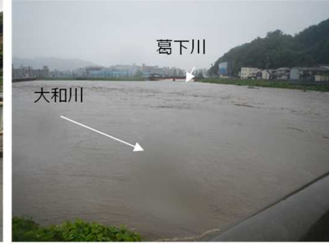
出水時（大和川27.0k付近）
