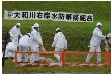
水防団による訓練 (改良越水止めネット工)
