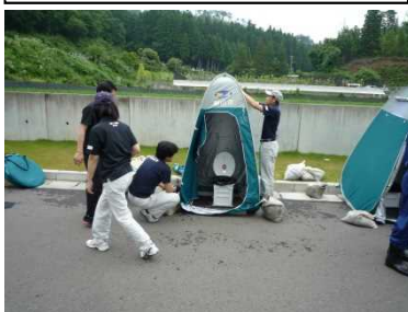
簡易トイレ設置
