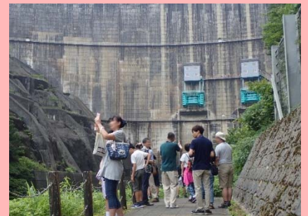
【下流部からのダム】
