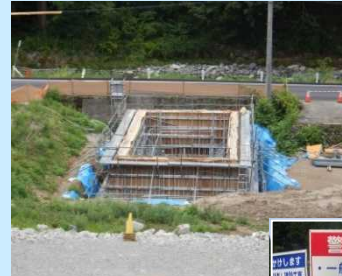
←濁水対策の事例 (施工中の沈砂池)
