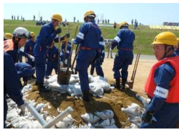
水防団による訓練 (釜段工)
