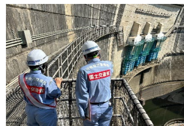
ダム堤体点検
