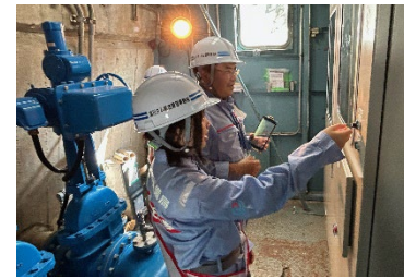
ゲート設備点検
