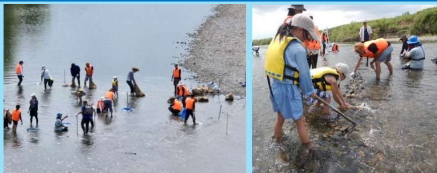
河床を掘り起こして大きな石を取り除くことで局所的に流れや水深を変化させ、アユが産卵する砂礫が多くなるよう整備を行いました。
