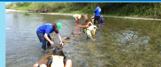
河床耕うんで除去した石を積み上げてバーブエを設置し、川の流れに変化をつけました。
