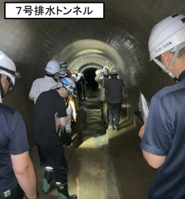
7号排水トンネル
