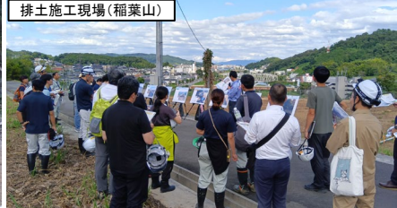
排水施工現場(稲葉山)
