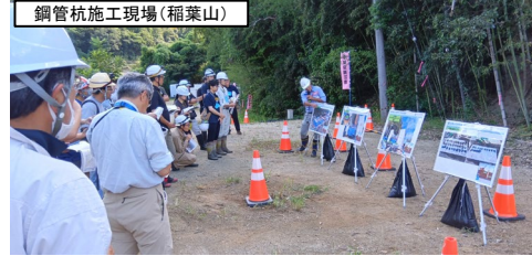
鋼管杭施工現場(稲葉山)
