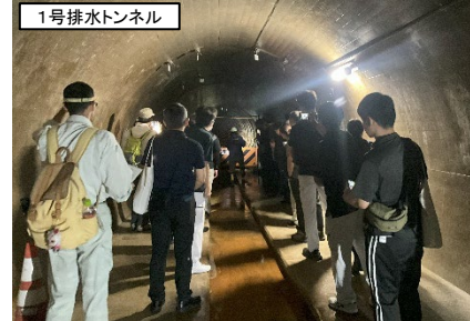
1号排水トンネル
