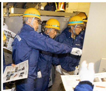
水防団による施設操作状況
