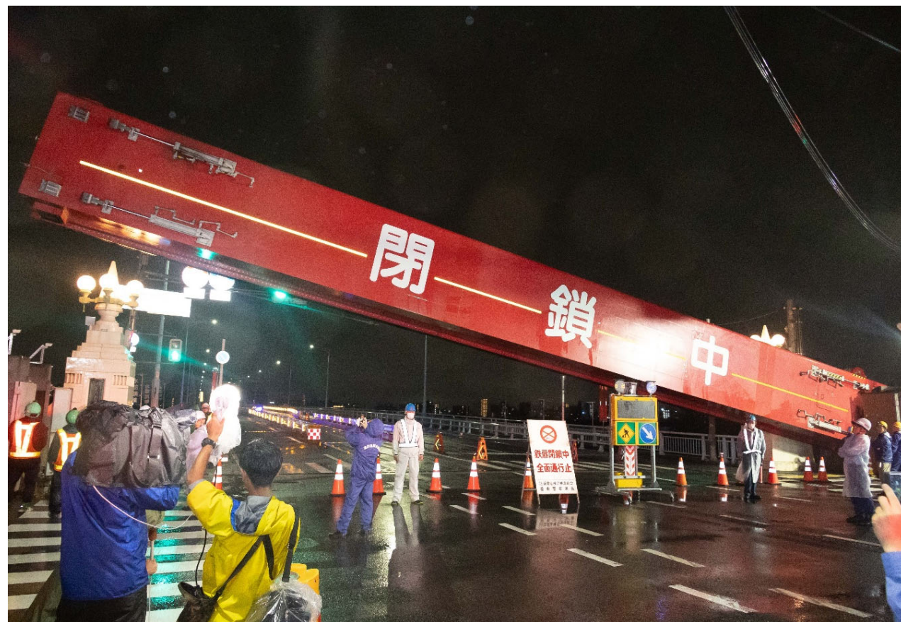
淀川陸閘 閉操作作業中 1時10分 (国道2号 淀川大橋左岸)
