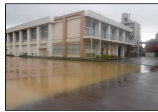
雨水流出抑制施設(枝庭貯留)
