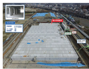
雨水貯留施設(安満遺跡公園)
