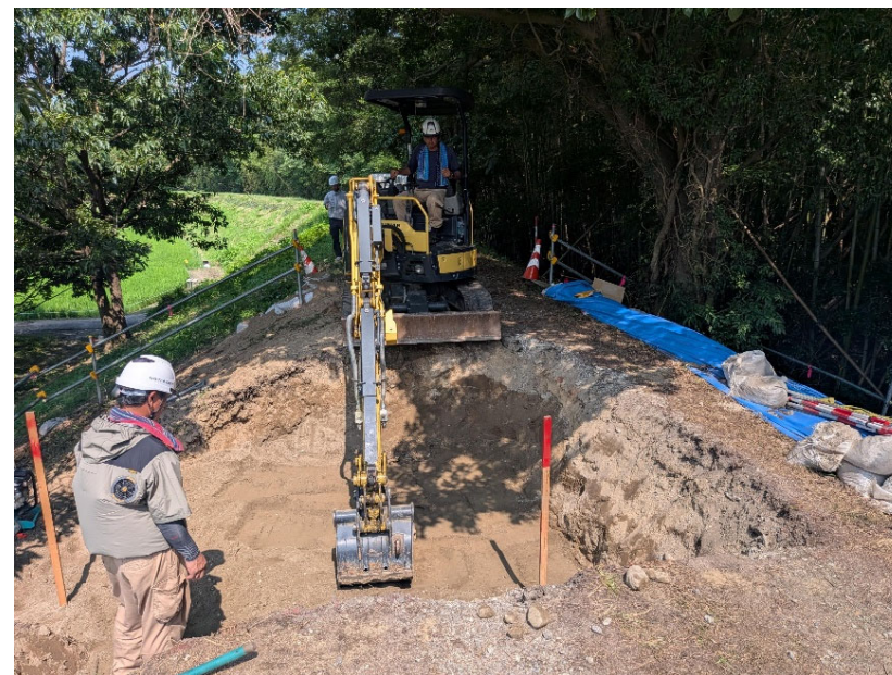
改良土による埋め戻し作業実施状況（下流側より撮影）
