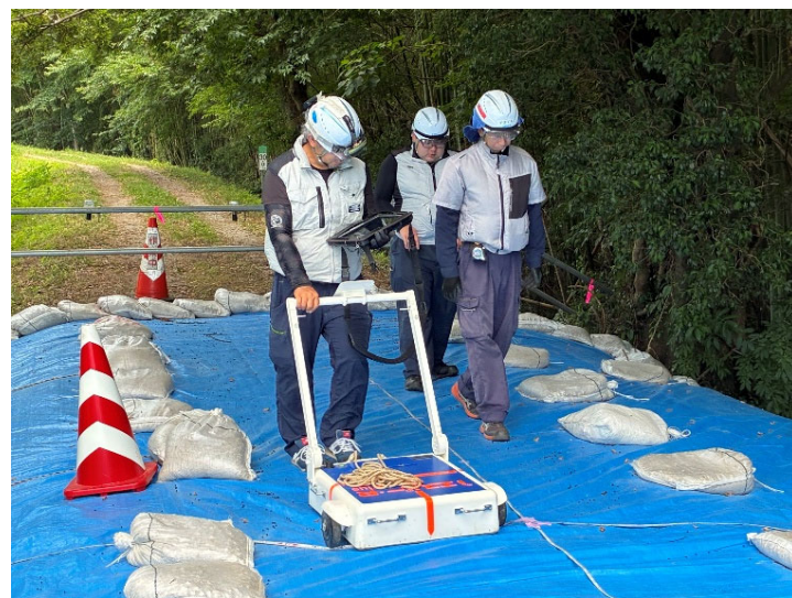
堤防天端の計測
