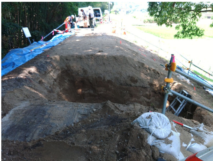
改良土による埋め戻し作業実施状況（上流側より撮影）
