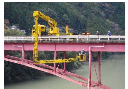
【維持管理設備がない】
