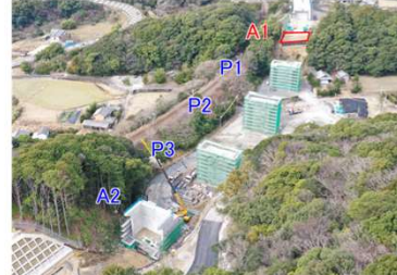
②すさみ町里野(小河瀬谷川橋)
