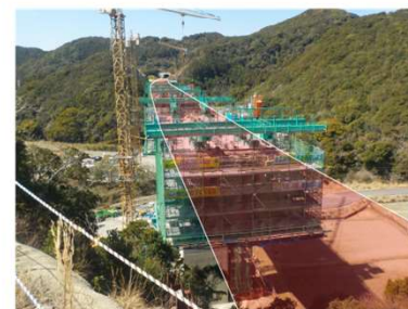
⑦串本町閼野川(閼野川橋)
