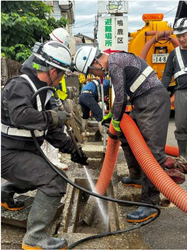
側溝内の堆積土砂に高圧噴射しながら側溝清掃車で吸引している状況
