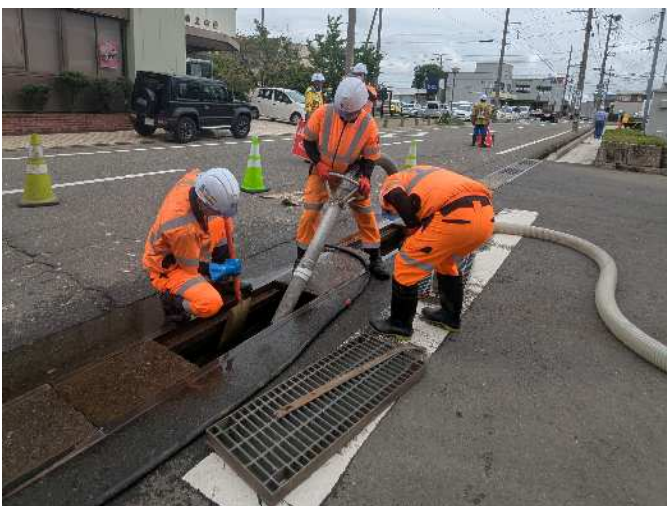
側溝内の堆積土砂を側溝清掃車で吸引している状況
