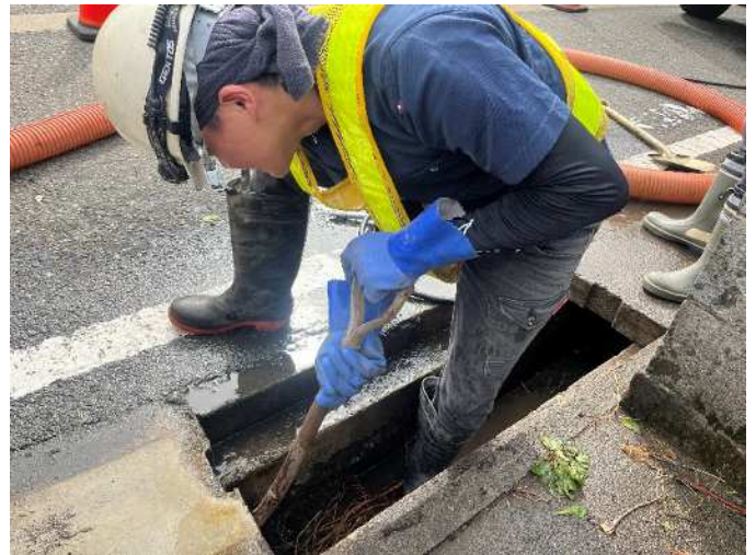
側溝内の堆積土砂を人力で撤去している状況
