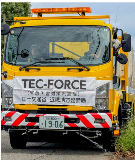
路面清掃車で路肩に堆積した土砂を撤去している状況
