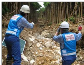
土砂災害調査
