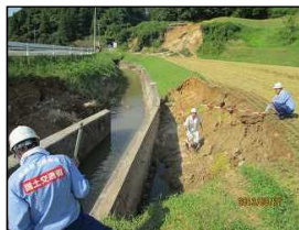
被災状況調査
