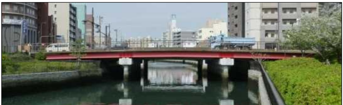
▲住吉橋 側面全景(上流側より)
