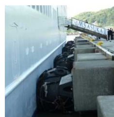
防舷材の取替え
