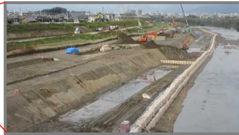
▲桂川 河道掘削状況
