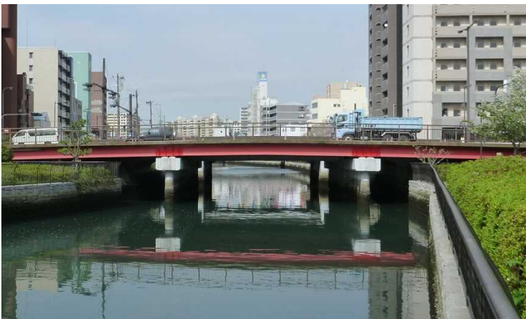
住吉橋の現況(全景)
