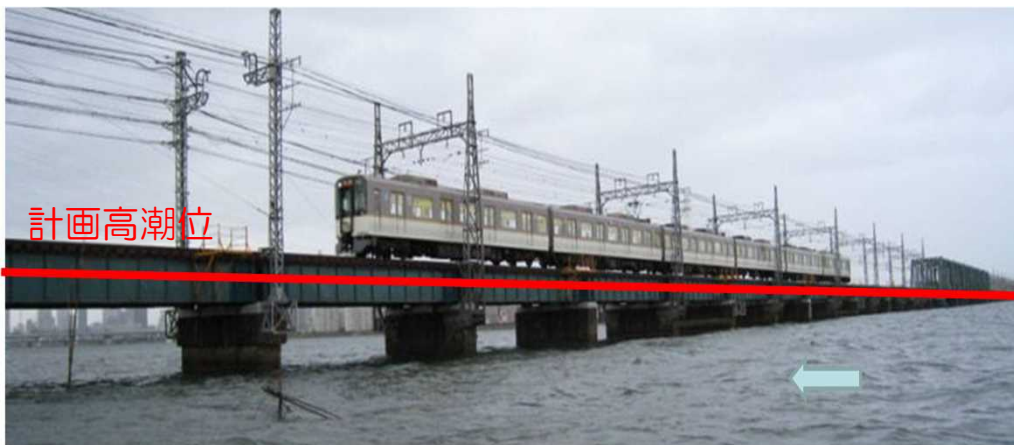
▲ 淀川下流部の中で最も低い橋梁で、洪水の流下阻害の要因
