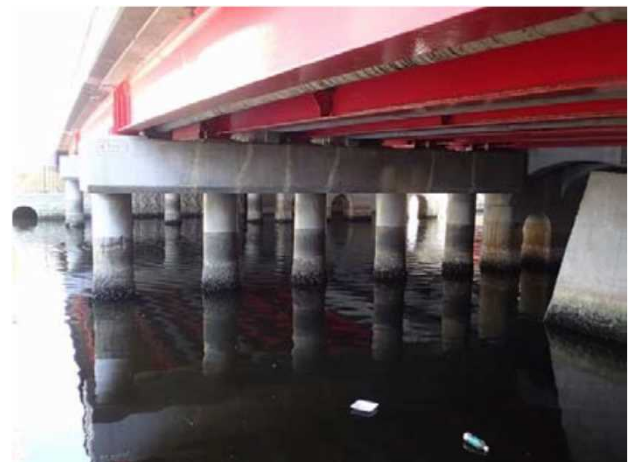
住吉橋の現況(橋脚)
