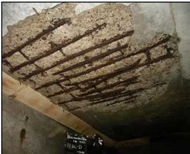
【床版のコンクリート剥離、鉄筋腐食】
