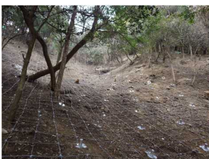
ハード対策(斜面对策工)
