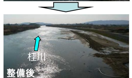
桂川河道掘削整備事例 (京都市伏見区 羽東師地区)
