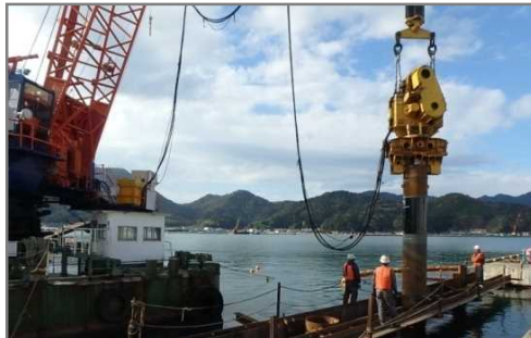
【対策状況(鋼管杭打設)】
