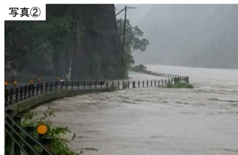
熊野川氾濫による道路冠水状況 (H27.7 新宮市高田)
