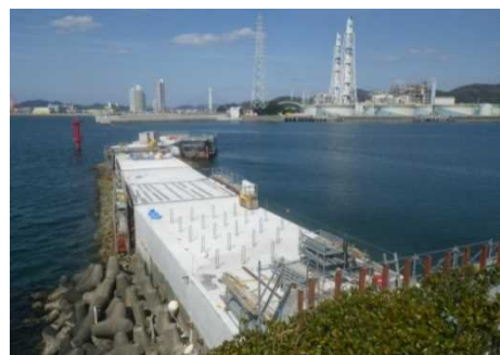
津波防波堤の整備状況
