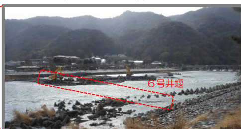
▲桂川(嵐山地区) 6号井堰撤去状況
